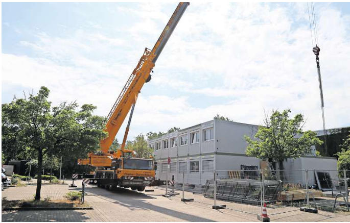
Mit einem Kran wurden die Container aufgestellt.
