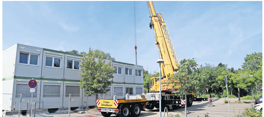
Mitte August wurden die Container am Ratsgymnasium aufgestellt, in denen mobile Klassenzimmer untergebracht werden sollen. Doch bis zum Schuljahresbeginn sind sie nicht fertig eingerichtet.
